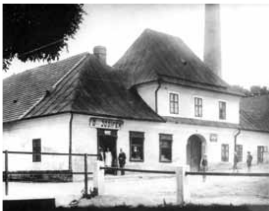
Dům č.p. 138, bývalá panská palírna. Bydliště Eislerových.
