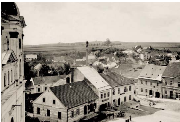
Záběr, pravděpodobně, z rozestavěné budovy spořitelny. Vlevo špalíček budov č. p. 163 (dům Vavřince Šabarta), č. p. 167 (dům Beneše Sklenáře) a č. p. 166 (dům Víta - kožešníka). Foto H. Jeřábek, 1930.
