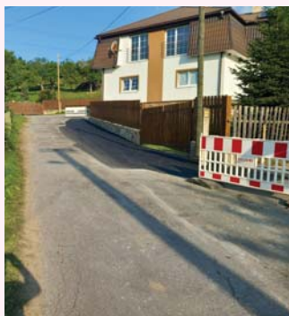
Kozlov - dokončení dešťové kanalizace a oprava komunikace
